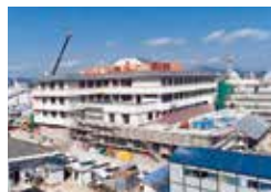
建設中の倉敷平成病院 1987 (S62)年
